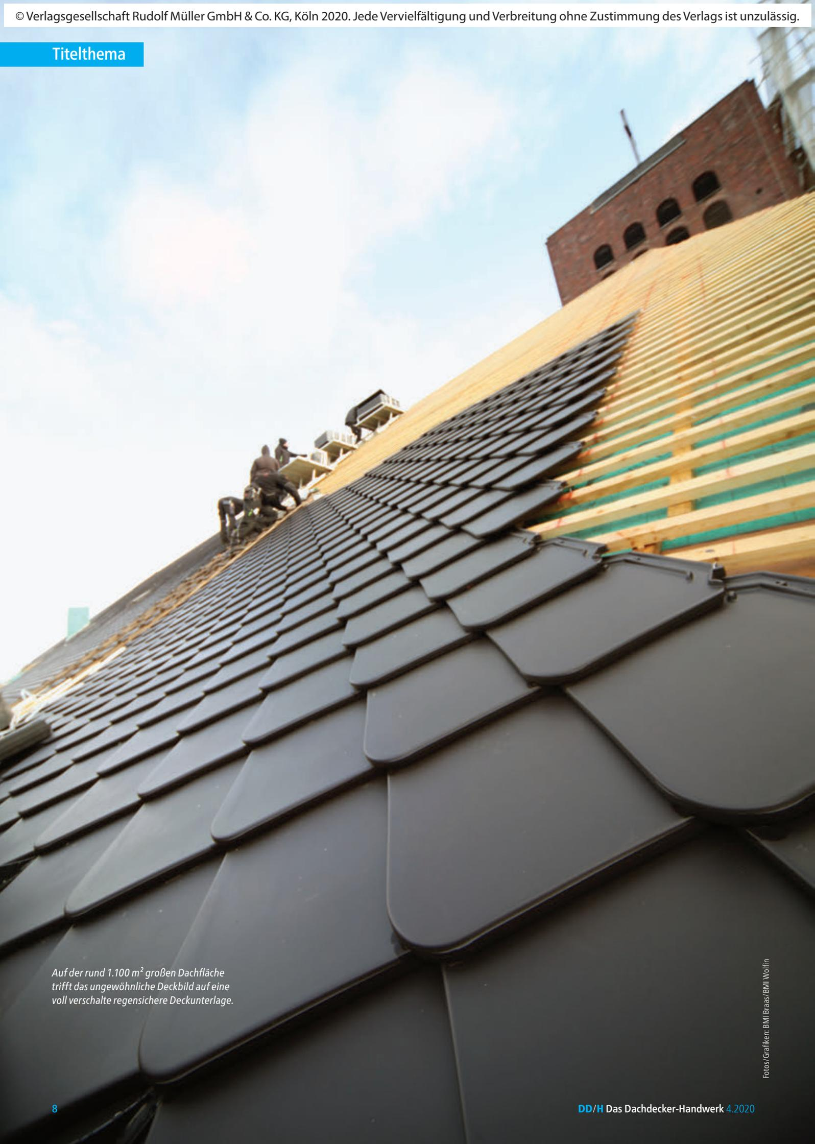
*Auf der rund 1.100 m<sup>2</sup> großen Dachfläche trifft das ungewöhnliche Deckbild auf eine voll verschaltete regensichere Deckunterlage.*
